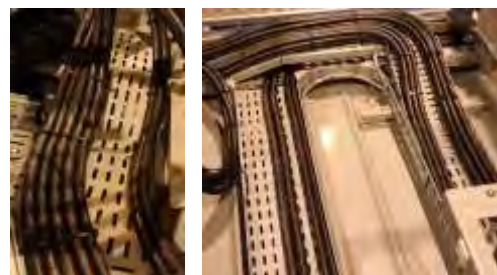
Kaapeleiden erottaminen raitiovaunun katolla
